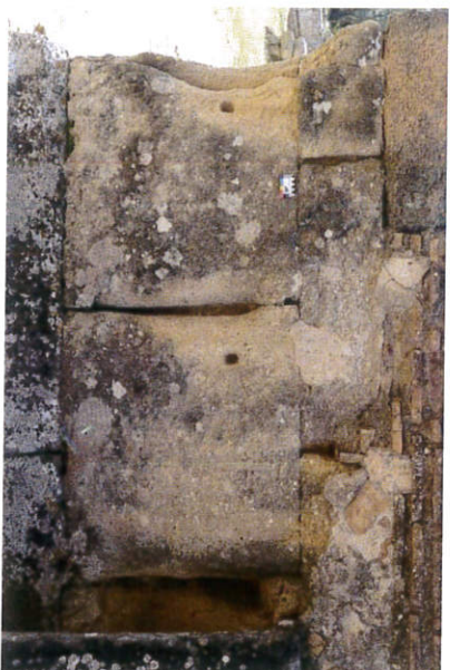
Εικόνα 21. Αποσάθρωση δομικού υλικού (DAI Athens)
