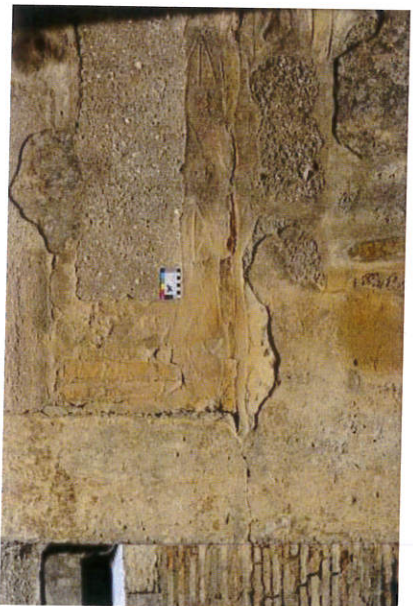
Εικόνα 19. Αρβετοκονιάματα (DAI Athen)
