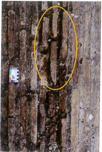
Εικόνα 27. Ατύλεια αυθεντικού κονιάματος αρμοδόνησης-δόμησης (DAI Athen)
