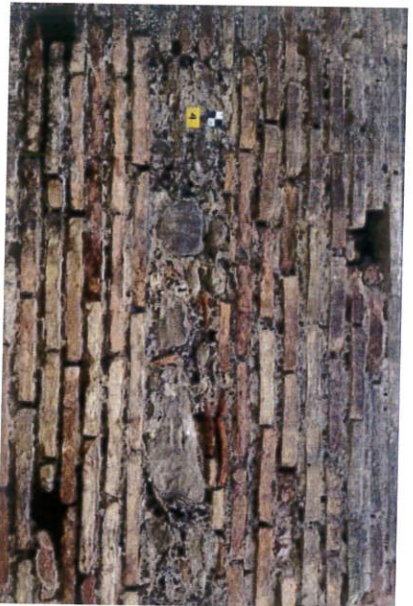
Εικόνα 18. Οπτή άργιλος και σενάζι από λίθους (DAI Athen)
