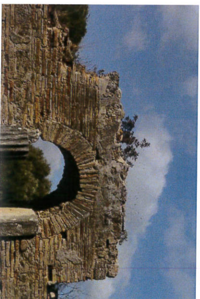
Εικόνα 25. Δρόση γλυφίδας - ανεπιθύμητη βλάστηση (DAI Athens)
