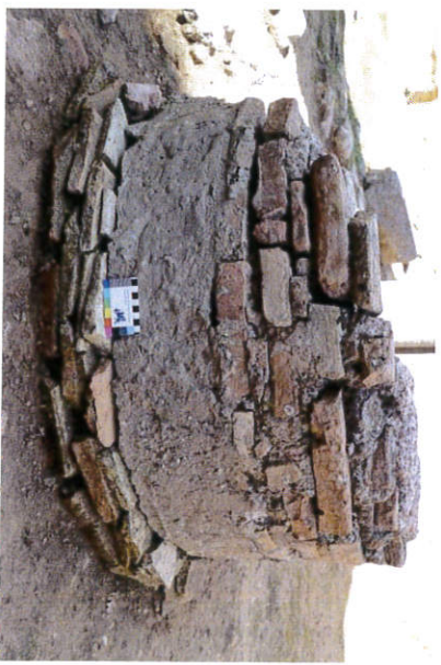
Εικόνα 32. Προηγούμενες επεμβάσεις. Συγκράτηση με κονίαμα ρωμαϊκής αββάδους δέξαμενης στο ιερό (DAI Athen)
