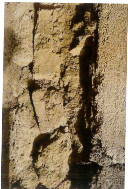
Εικόνα 20. Πηλοκονιάματα (DAI Athen)
