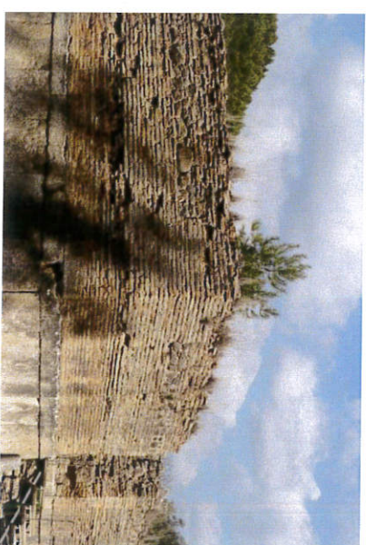
Εικόνα 26. Δρόση γλυφίδας - ανεπιθύμητη βλάστηση (DAI Athens)
